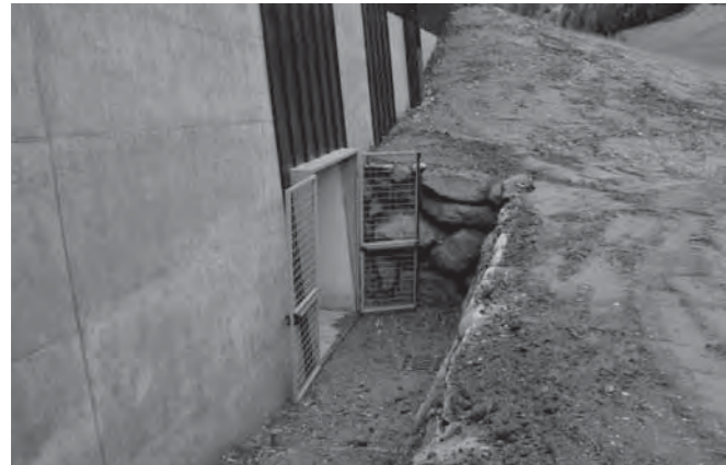
Notausgang des Tunnels „Eissteg“
