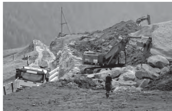
Die Bauarbeiten in vollem Gange – 16. September 2010
