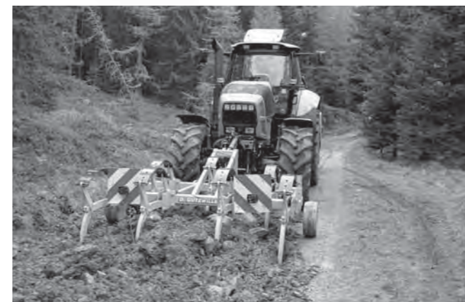
Arbeiten an der Straße Ameiserberg
